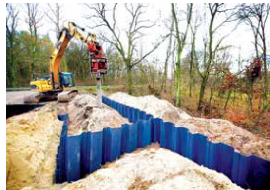
Rysunek 3 i 4. Poglądowe zdjęcie grodzic stalowych i PVC, (na dole o wysokości ok. 5,0 m)
