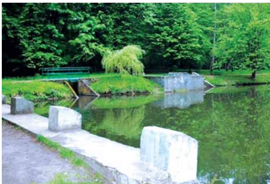
Fot. 4. Nabrzeże pływakie, taras ze schodami oraz budowla wpustowa. Rok 2013
